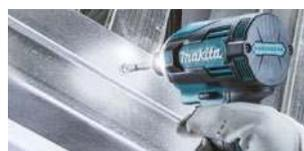
Colocación de tornillos auto perforantes en metal delgado como perfilaría.
