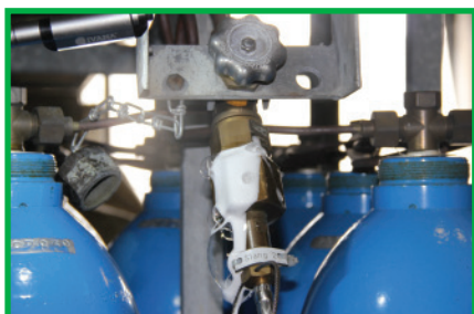
Comprobación de uniones roscadas
