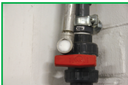
Comprobación de equipos de gas estanco
